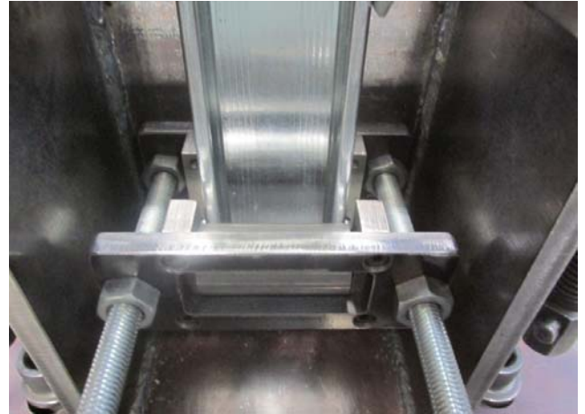
(b) 振れ止めの設置状況(加力方向:野縁方向)
