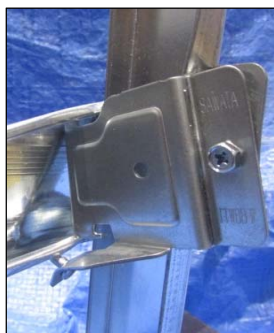
(a) 破壊の状態A (正側)
