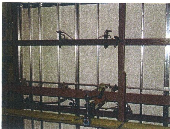
写真-7 変位計の設置状況（天井裏側）
