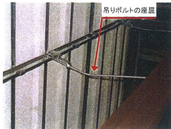
写真-10 試験後の状況（天井裏側）
